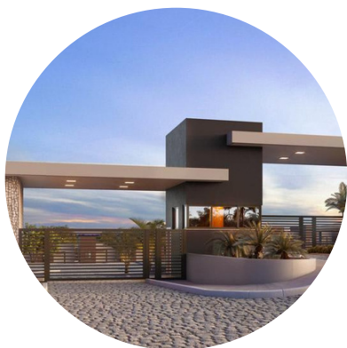
Portaria de acesso
